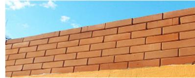
PLATIBANDA EM ALVENARIA TIJ. ECOLÓGICO EMPILHADOS
